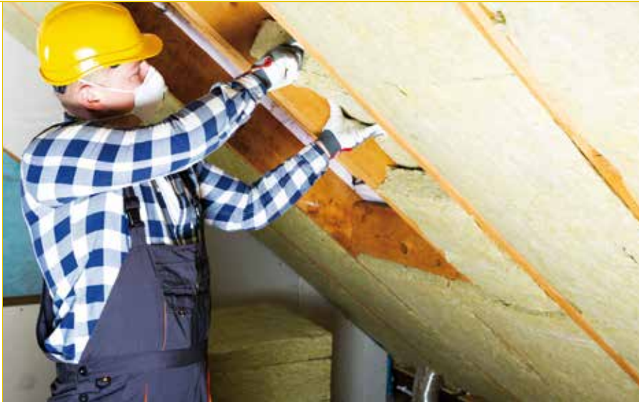
Die Dachdämmung ist Teil der energetischen Sanierung eines Hauses
